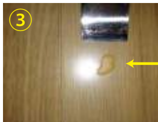
固まるまでまってから スクレーパーで削る
